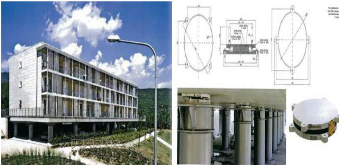
Figure 6. Aquila bâtiments du quartier et le système de pendule de frottement utilisés
