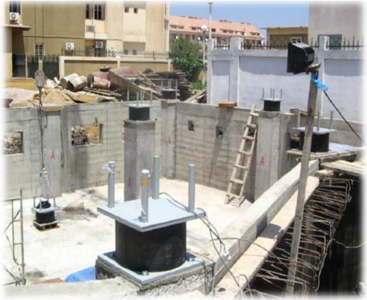
Figure 9. Installation des dispositifs parasismiques [6]
