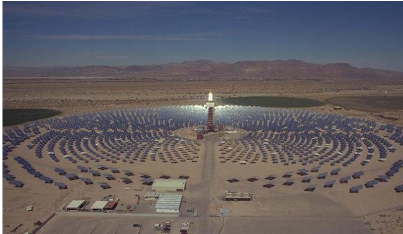
Figure II.16: Système de centrale à tour.
