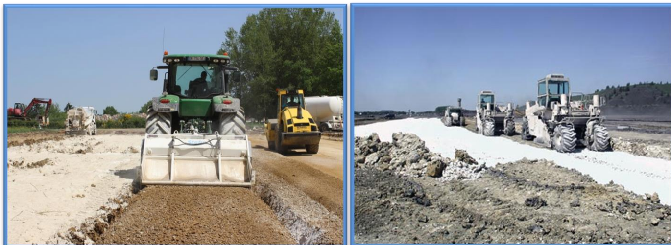
Figure I- 14: Traitement des sols à la chaux
