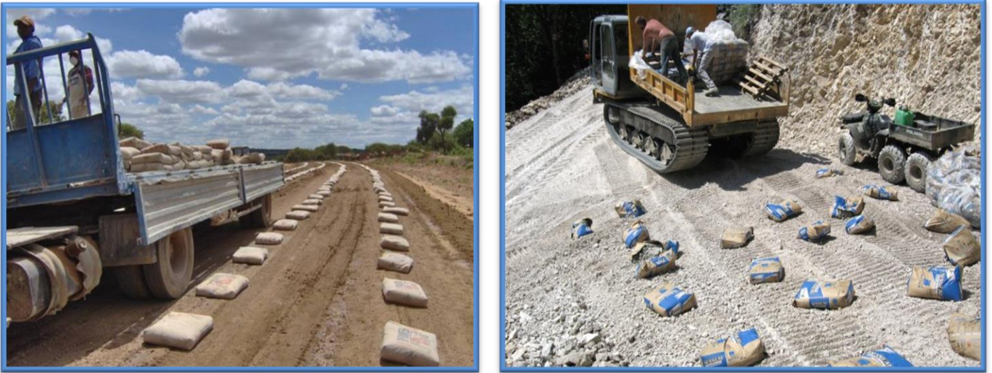
Figure I- 16: Procédé classique d'épandage du ciment.
