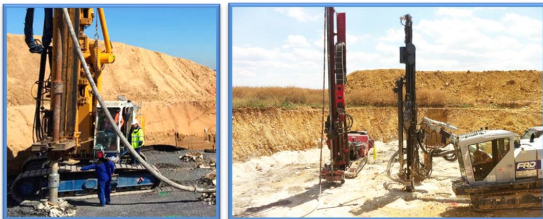
Figure I- 11: traitement des sols par injection
