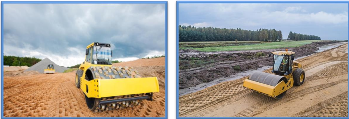
Figure I- 10: Compactage de Sol par Rouleau de Route
