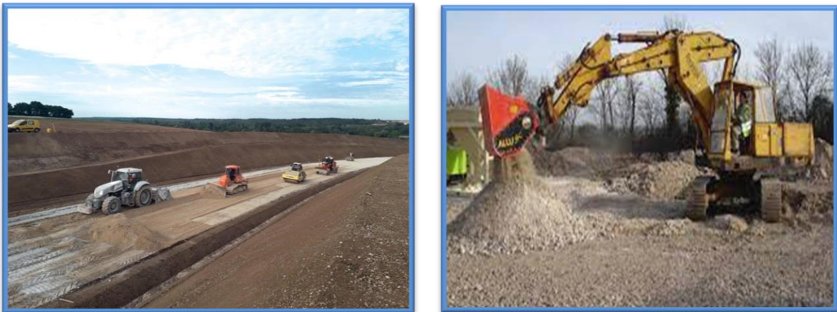
Figure I- 15: Traitement a la chaux ou Ciment
