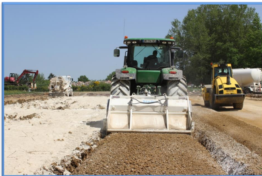
Figure I- 13: stabiliser des sols avec de la chaux ou du ciment
