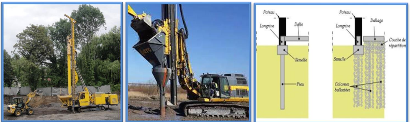
Figure I- 12: Colonnes ballastées pour amélioration des sols
