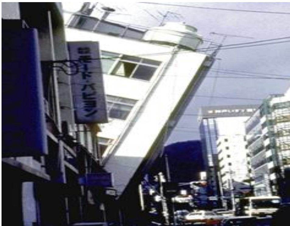
Figure (2-3) : Exemples de rupture des fondations lors d'un séisme : bâtiment à Kobé ayant basculé à sa base.
