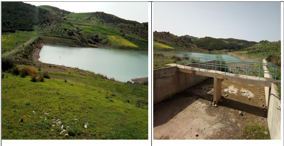
Fig.VII-A-1 : Digue écreteur de crues
