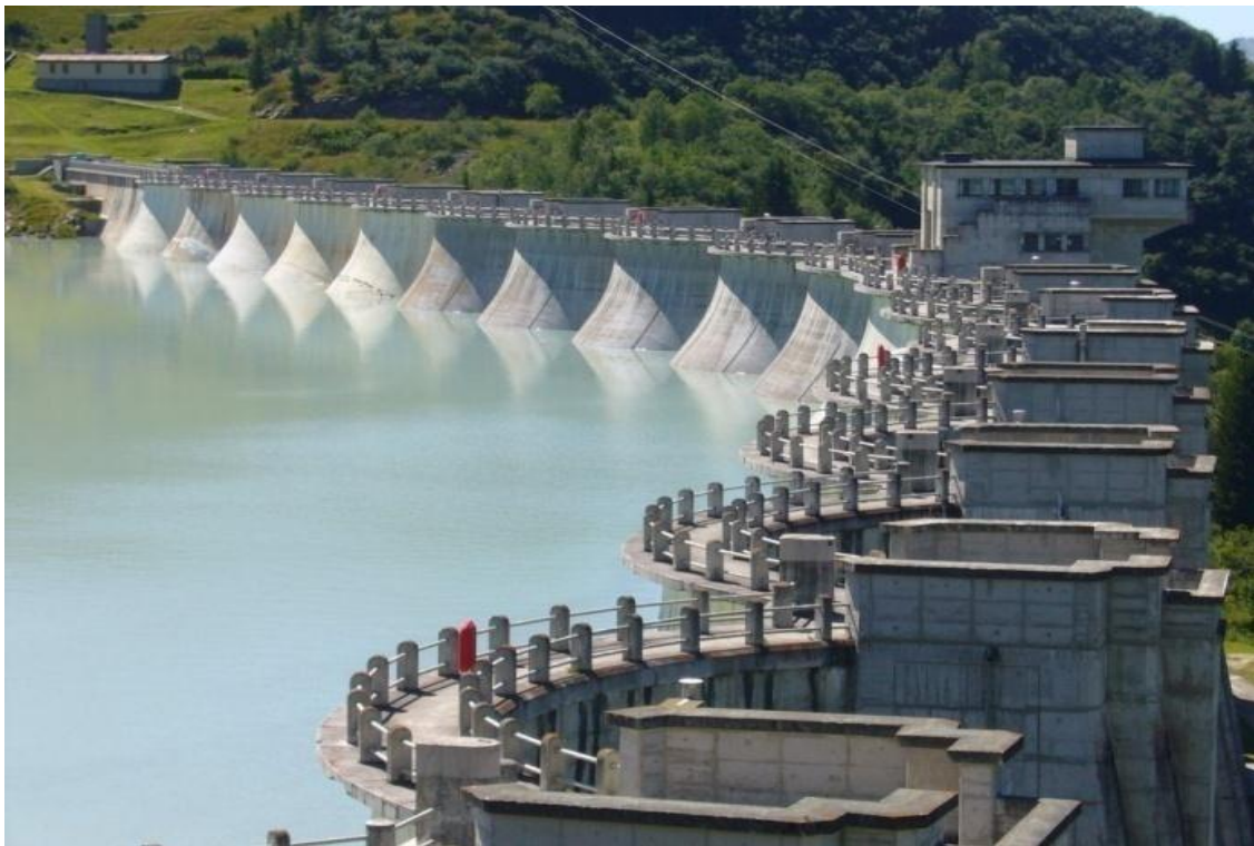
Figure 1.10 barrage de la Girotte- multi-voûtes
