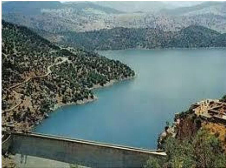
Figure V.1 : barrage-poid en béton de Oued Fodda
