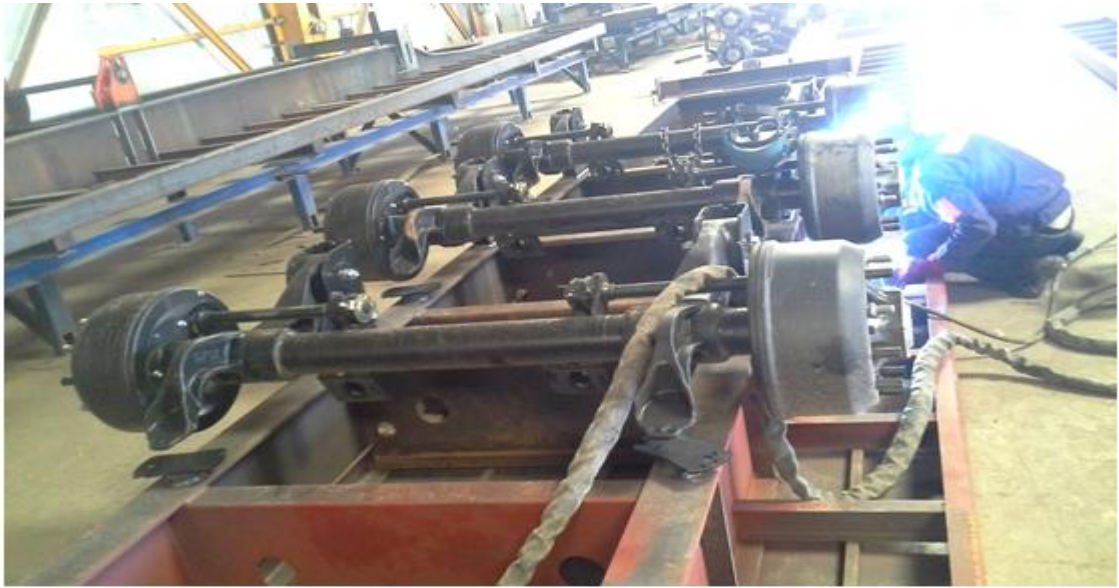
Figure I-21: finalisation le soudage ACI de M'sila.
