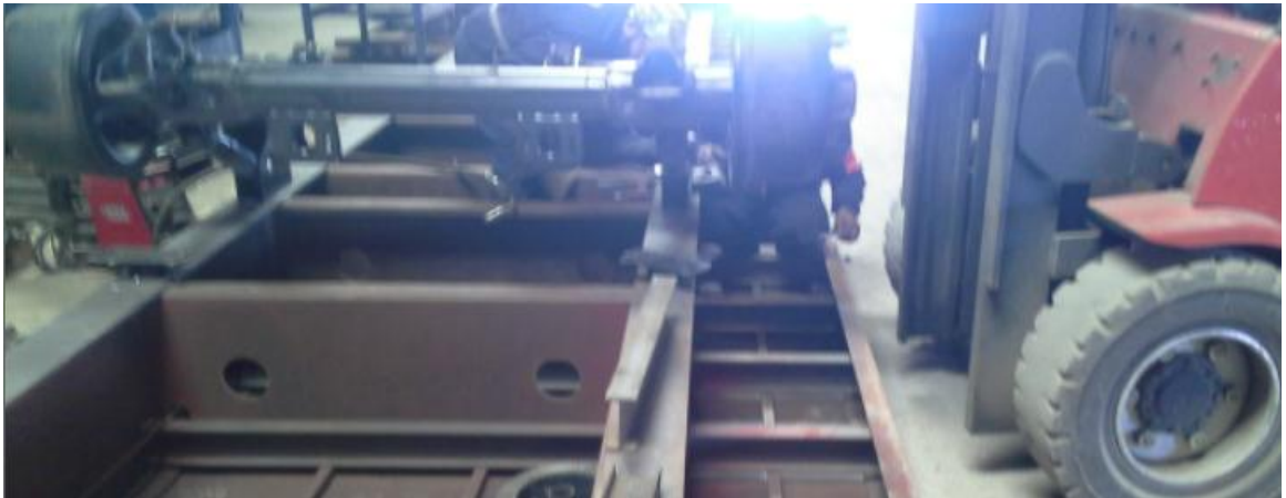
Figure I-18: Soudage les supports des roues
