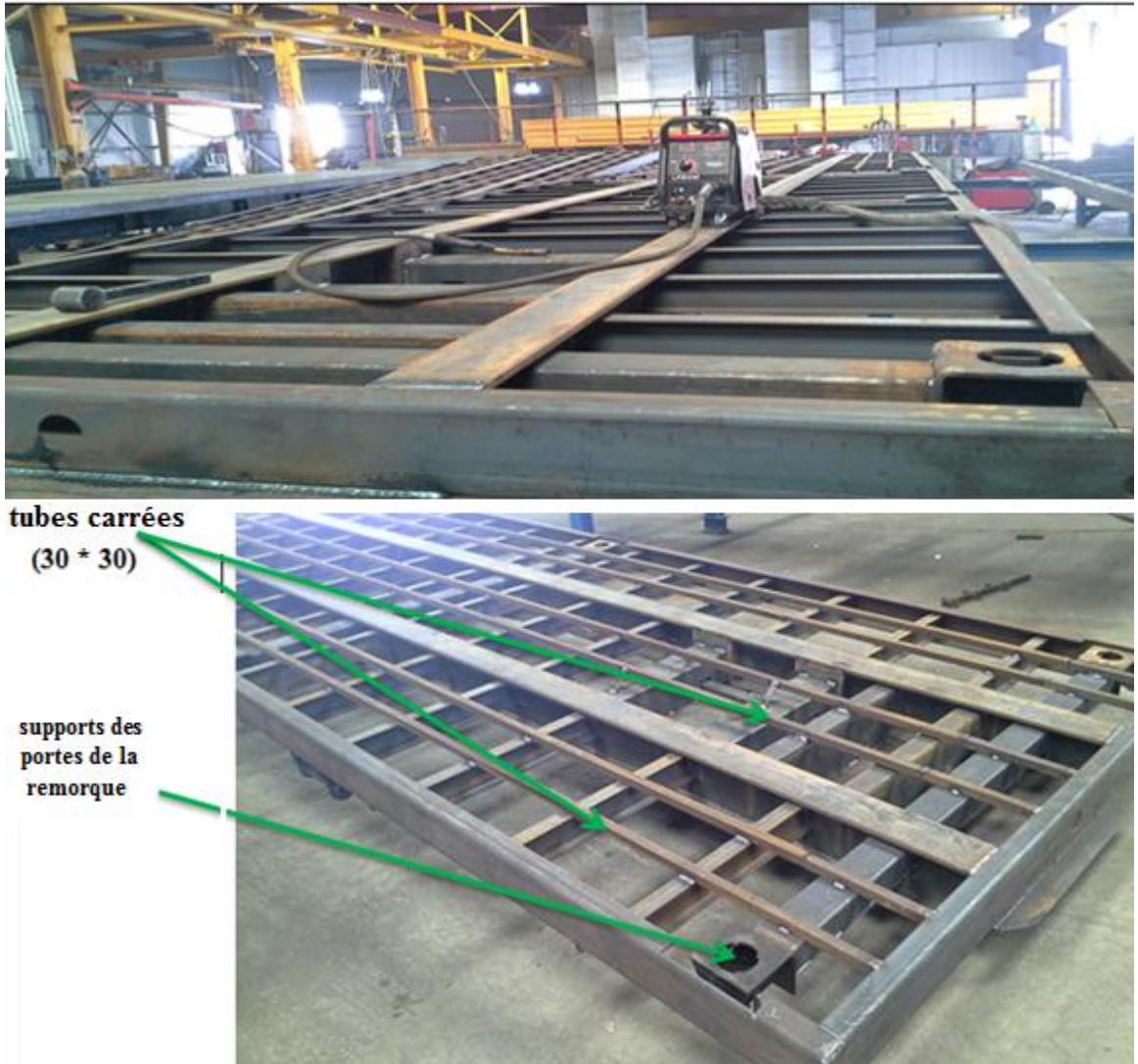
Figure I-27: Soudage les tubes et les supports des portes de la remorque.
