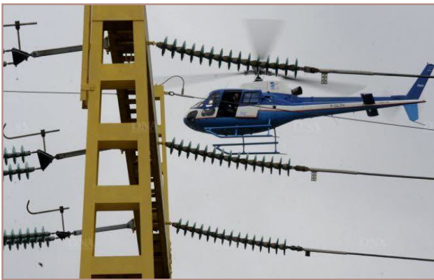
Surveillance des lignes électriques [b]
