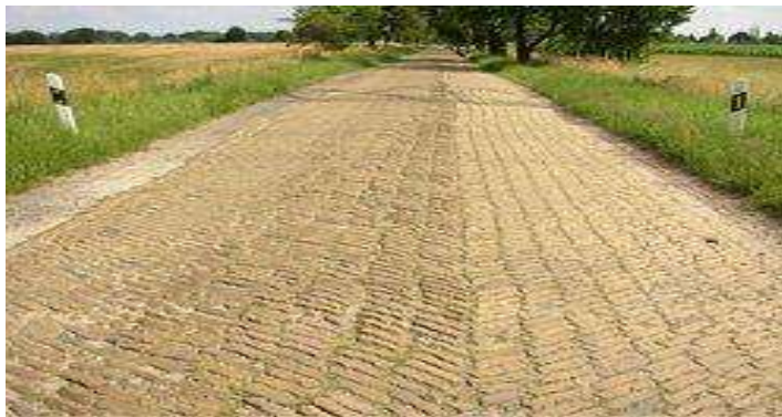
Figure 28 : Route Pāwesin-Riewend pavée de briques, dans le Brandebourg, Allemagne [26]
