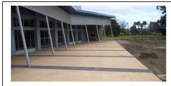
Figure I.3. Cour d'école en Australie en béton E-Crete® [31]
