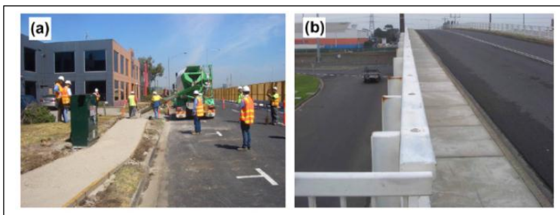
Figure I.46. E-Crete™ dans un port à Melbourne, Australie: a) 25MPa trottoir à travers de Westgate Freeway extension. b) 55MPa panneaux préfabriqués à travers du pont Salmon Street. [199]
