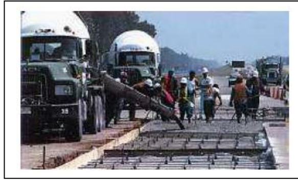
Figure I.2. Rénovation de route avec Pyrament® [31]
