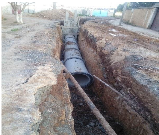
Photo n°04 : La mise en place des canalisations en tranchée
