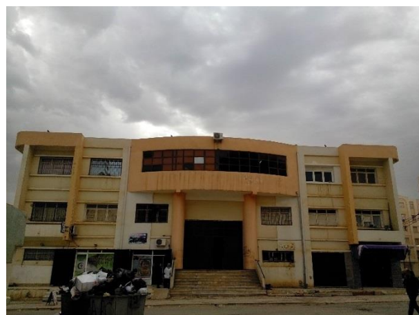
Photo n°16 : équipement (60 locaux) R+2.
