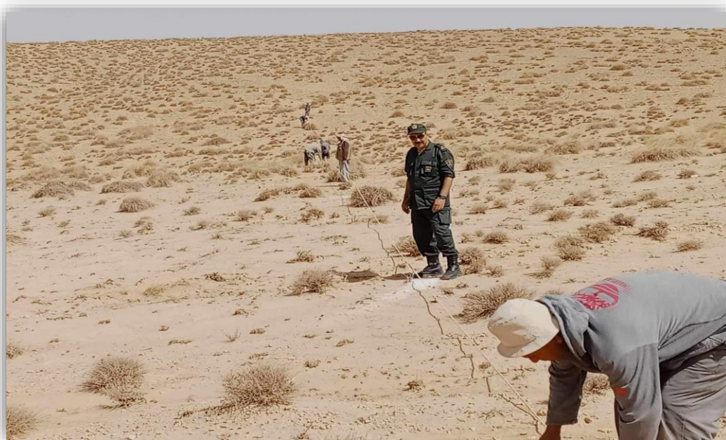
Figure II. 2 : traçage des lignes de creusement zone d'étude
