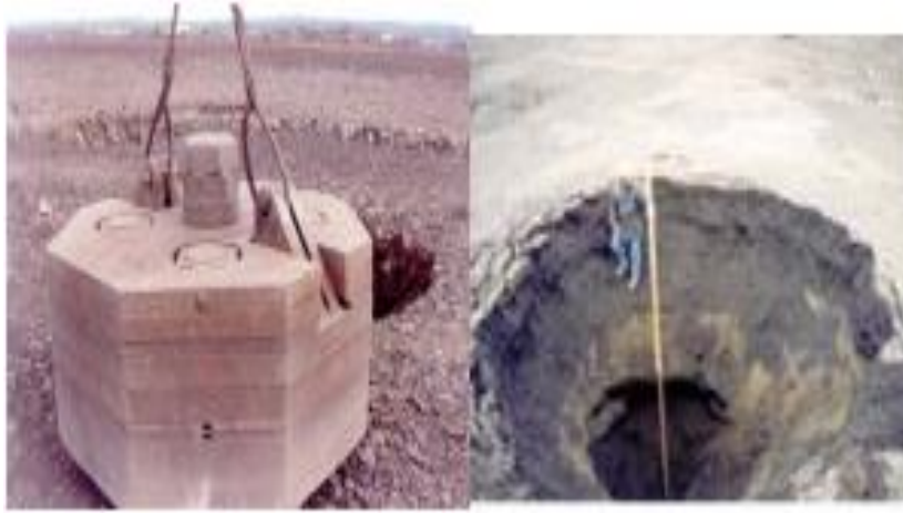
Fig : I. 4. Exemple d'un pilon (à gauche) et l'empreinte laissée après sa chute (à droite) (Document de Geopac ®) .
