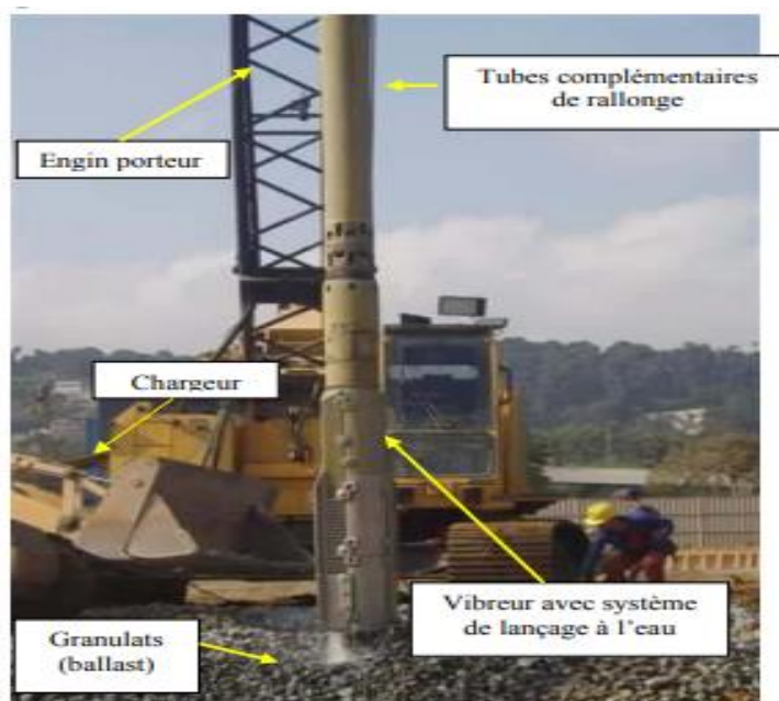
FigI.32 - Exemple de vibreur Keller (voie humide)
