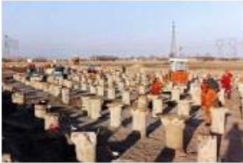
Fig : I.10 - Réseau d'inclusions rigides (Document de Soletanche Bachy®)
