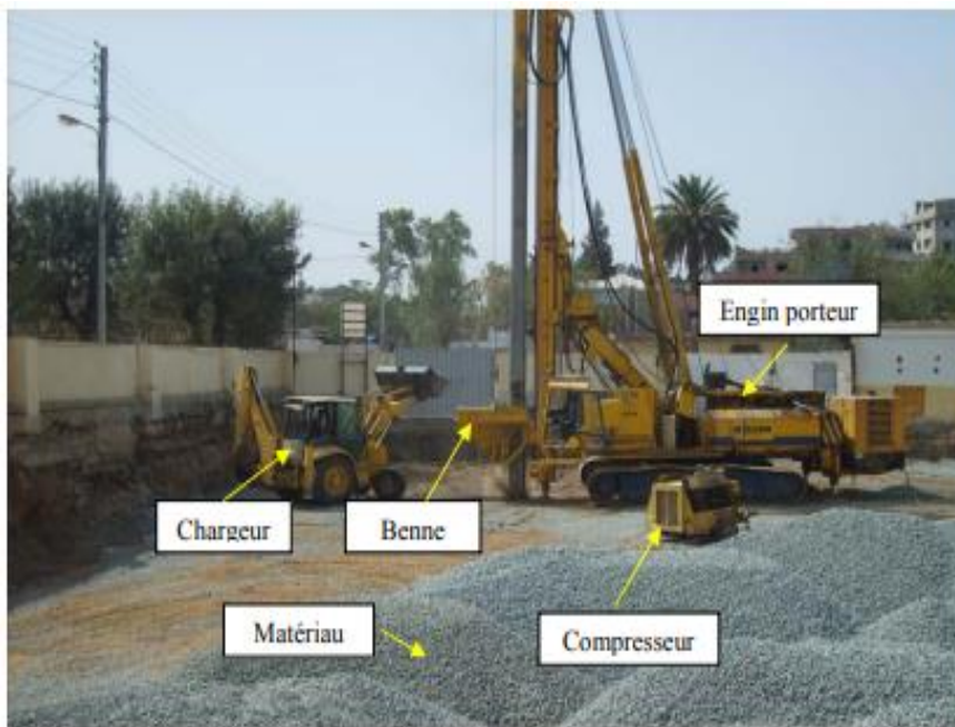
Fig I.30 – Exemple de vibreur Keller (voie sèche)
