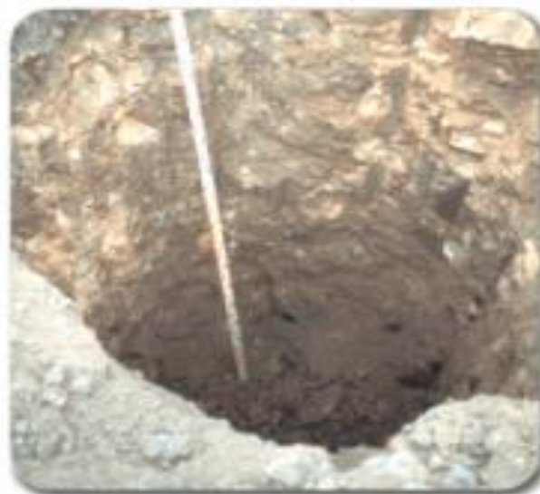
Fig : I.16 - Plot ballasté avant remblaiement type (Document de G.T.S®)
