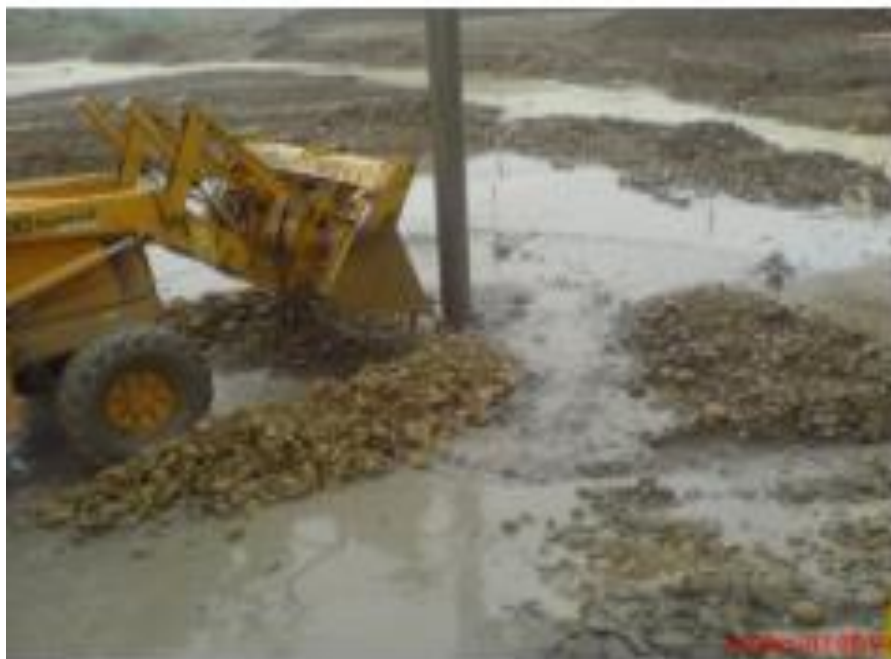
FigI.34 - Remplissage du trou par le ballast
