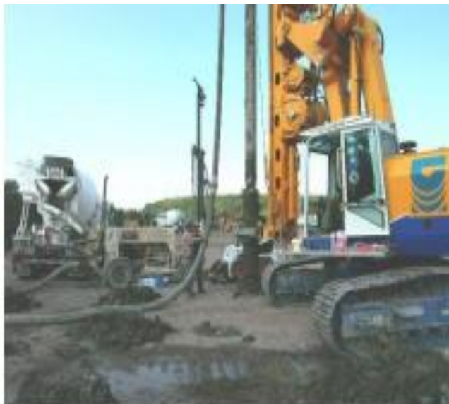
Fig : I.17 -Chantier de réalisation des Colonnes à Module Contrôlé
