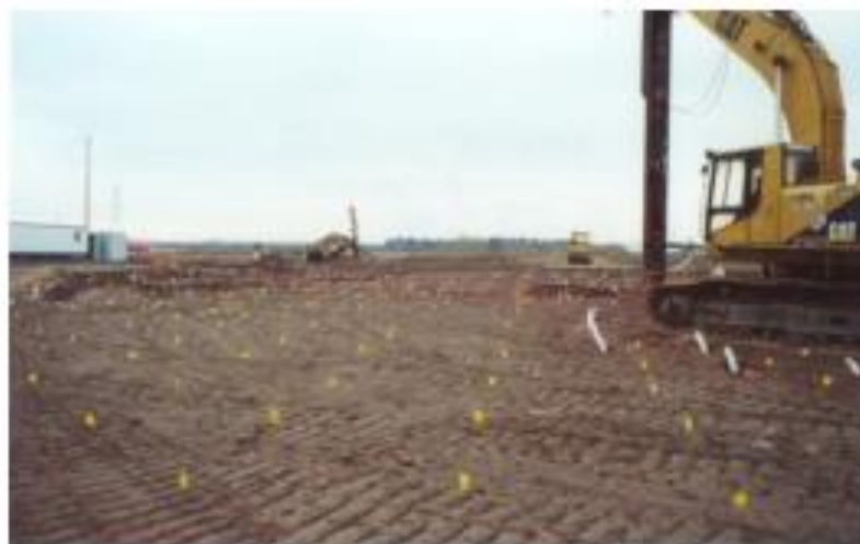
Fig : I.2.- Chantier de réalisation des drains verticaux (Document de Géopac®)
