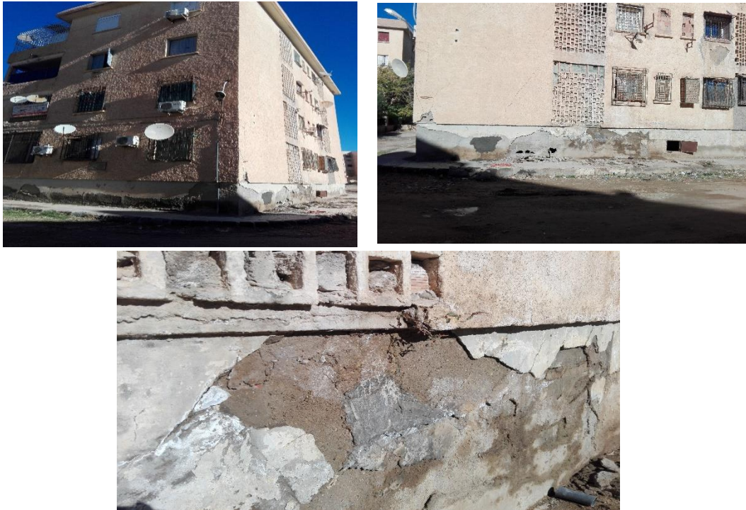
Figure III.10 Agressivité chimique (20 Logts El Hamel 2019)
