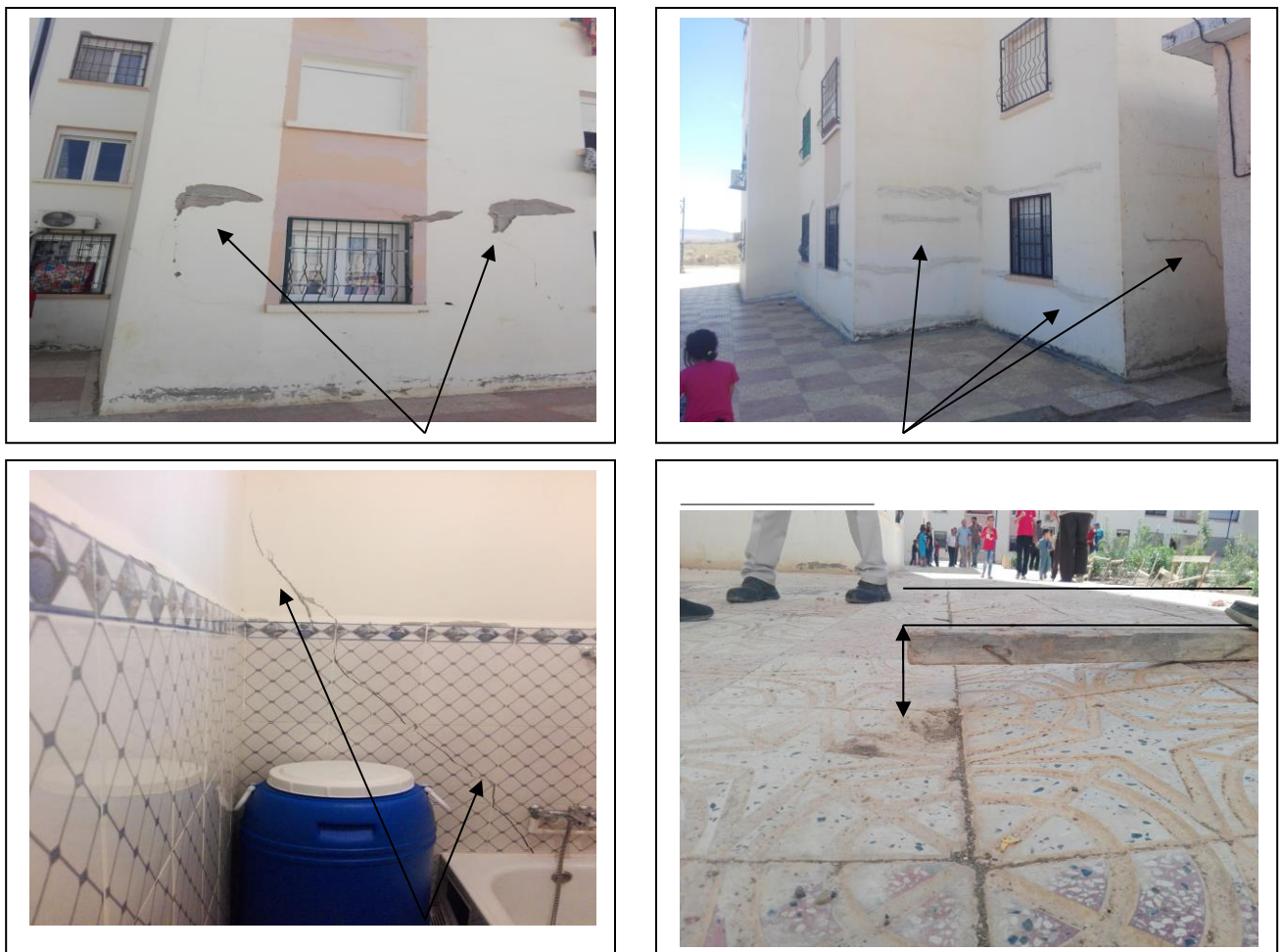
Figure III.8 Cas pathologique phénomènes retrait / gonflement (530 Logts Sidi Aissa 2020)
