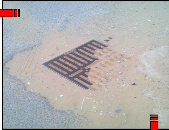
صورة رقم 21 : انسداد بالوعات المياه
