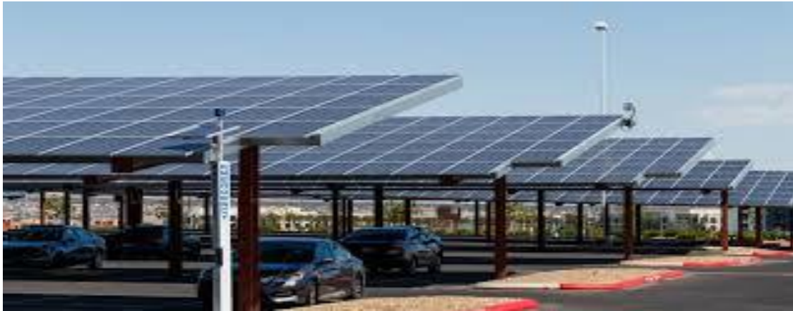
Figure 8: Systèmes photovoltaïques commerciaux [13]
