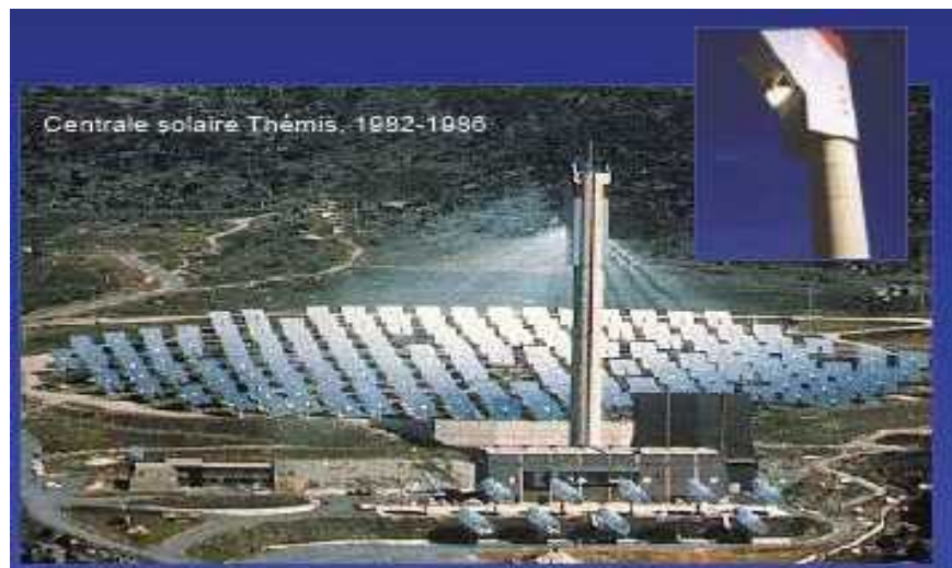
Figure I.15 : La première centrale expérimentale à tour, Thémis (France).
