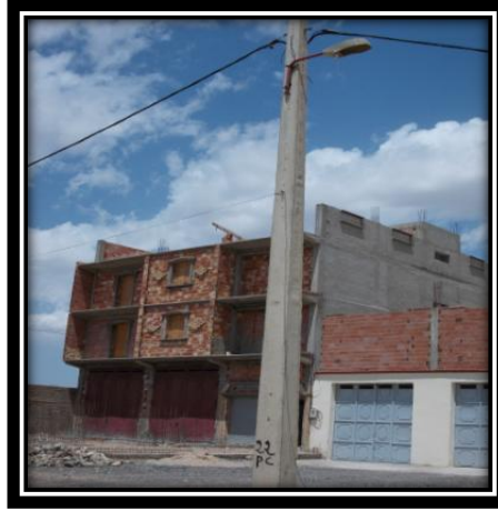
الصورة رقم(38):عمود كهربائي
