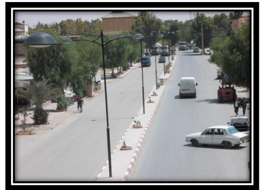
الصورة(29):سهولة الحركة بمحاذاة الطريق المزدوج
