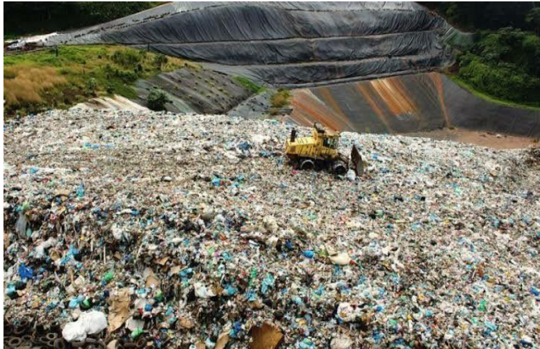
Figure 8 : Photo d'une décharge contrôlée.
