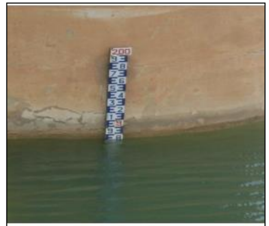
Photo III.2 : l'échelle limnimétrique sur la digue du barrage
