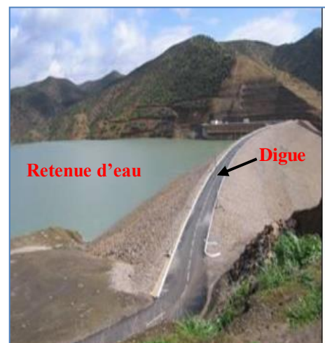
Photo II.4 : Retenue du barrage SMBT (Beddal, 2007)
