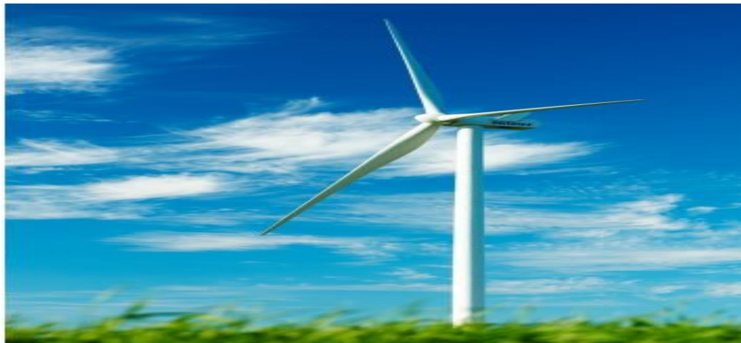
Figure I.4. Éolienne à axe horizontal
