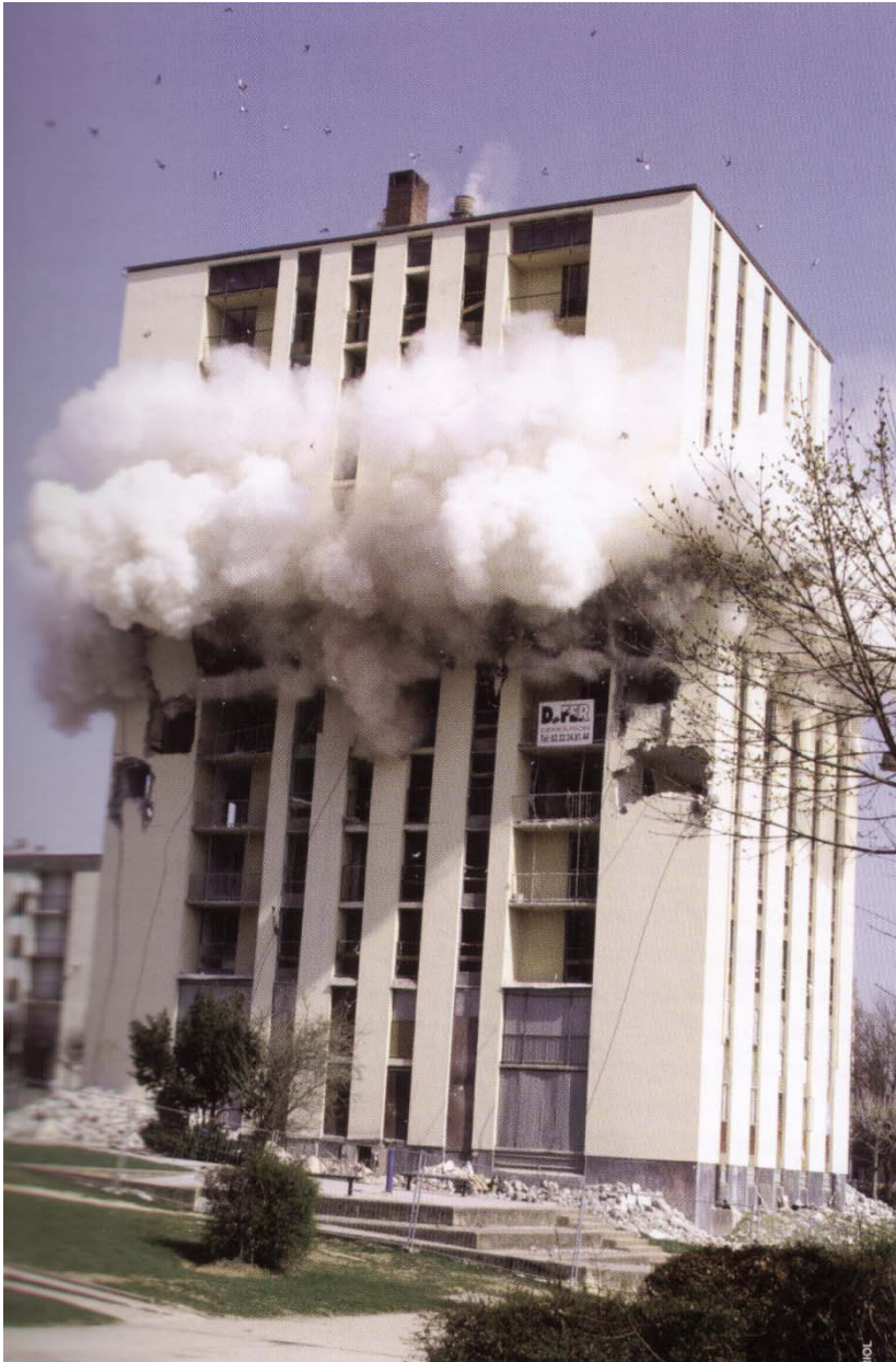
Figure 6: Démolition de la tour Bach à Reims.
