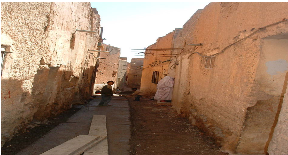
Figure 34: image sur les travaux entrepris par l'APC
