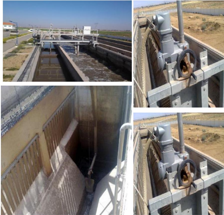
Figure I.4 : Vue générale de la station d'épuration des eaux usées de M'Sila [40].
