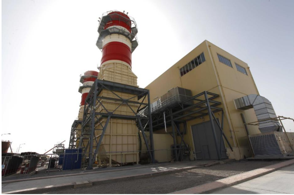
Figure I.5 : La centrale thermique de M'Sila.
