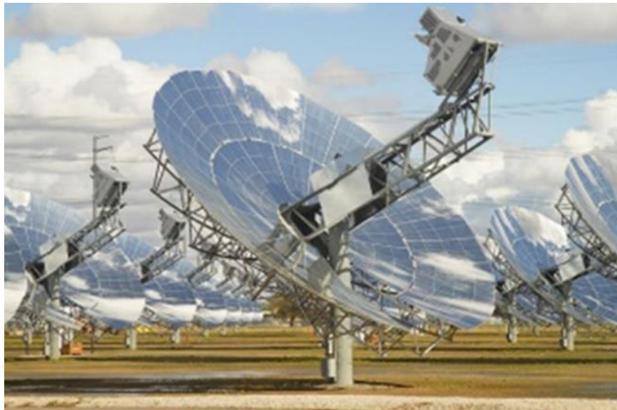
Figure I.11 : Concentrateur parabolique à Moteur Stirling [13].
