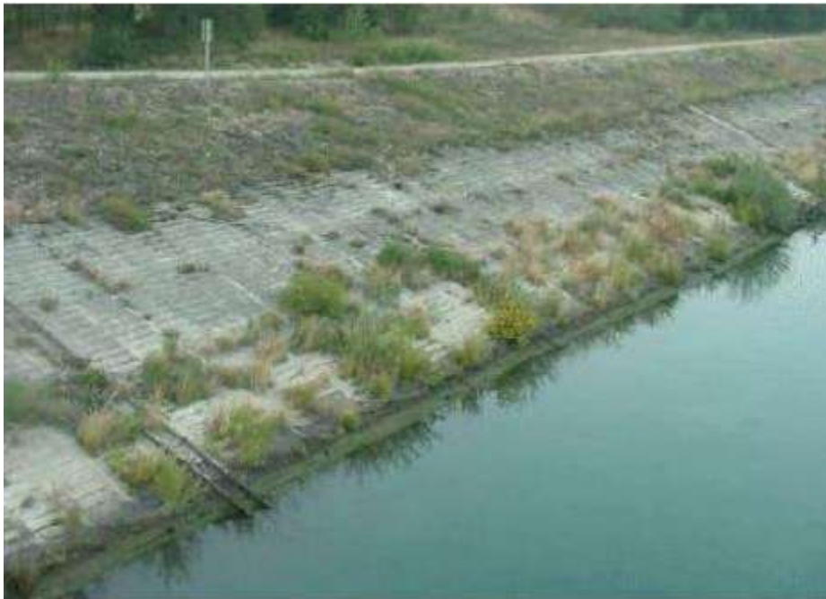
Figure IV-3 : Digue de navigation du Rhône en charge en permanence
