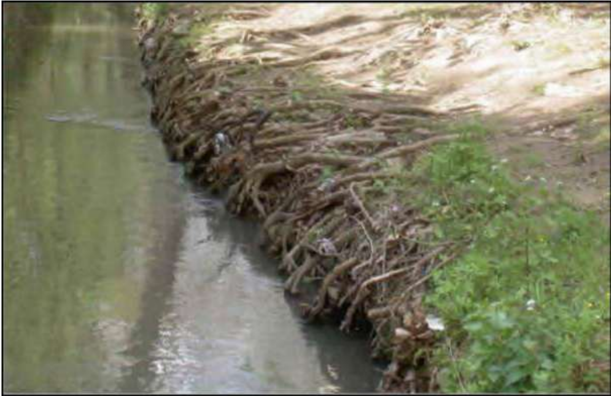
Figure IV-6 : Aménagement des berges de l'oued contre le glissement
