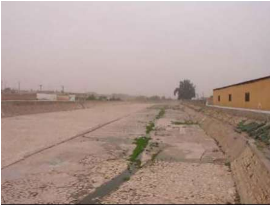
Figure IV-2 : Oued Mekerra (wilaya de Sidi Bel Abbès) rééquilibré dans la traversée de Ras El-Ma.
