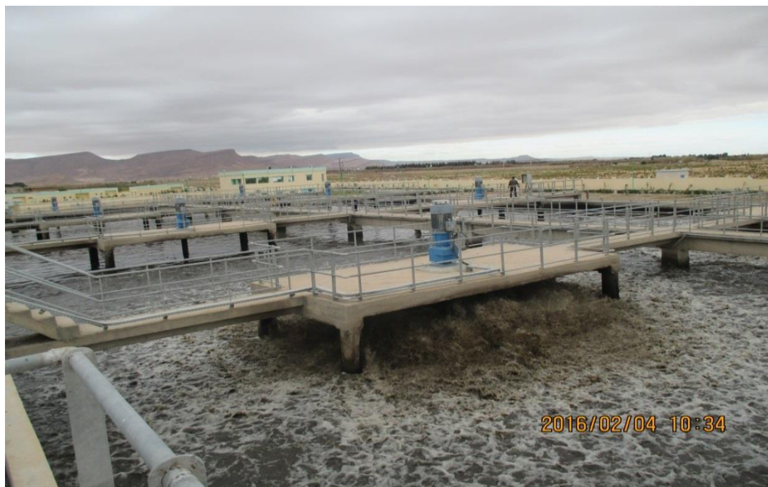
Figure II-13 : Modele d'un bassin anoxique (Photo de la STEP de la ville de Bou Saâda)
