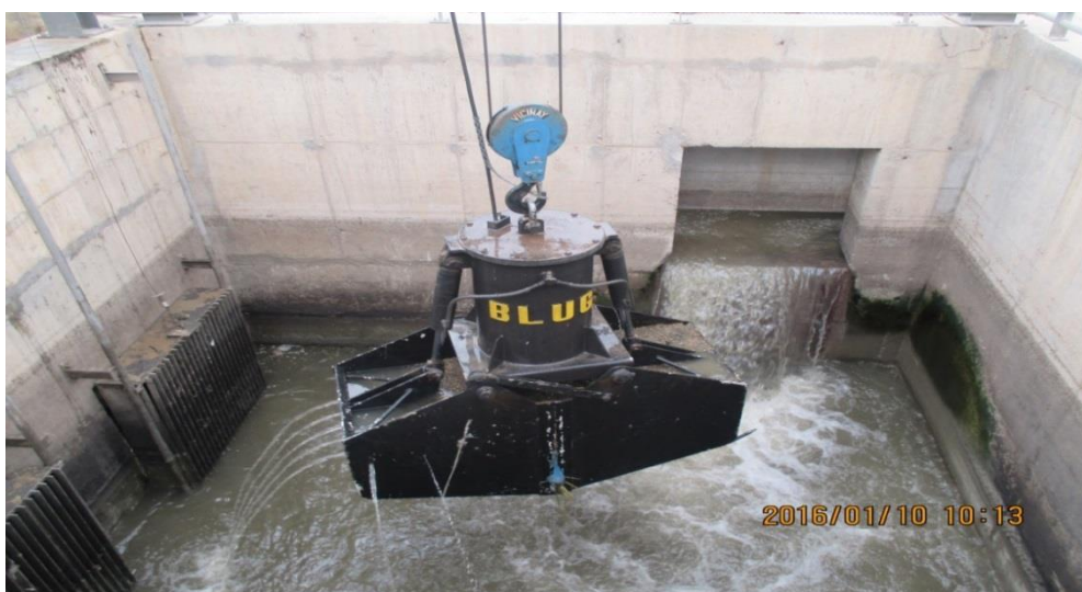
Figure II-8 : Enlèvement des résidus de terre et du gravier
