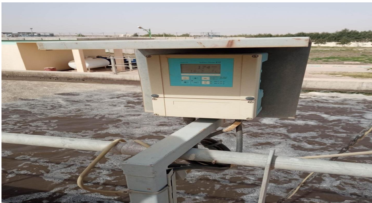
Figure II-14 : Modèle d'un bassin d'aération (Photo de la STEP de la ville de Bou Saâda)
