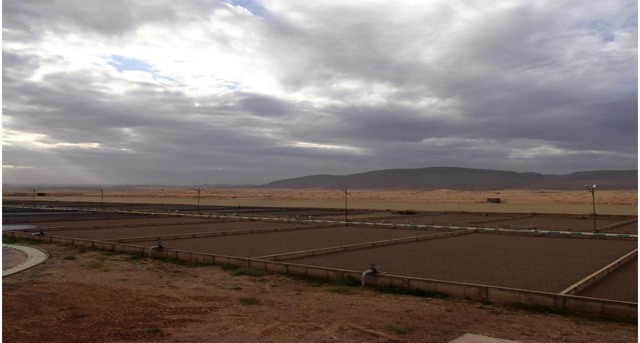
Figure II-17 : Les boues en excès déshydratées (Photo de la STEP de la ville de Bou Saâda)
