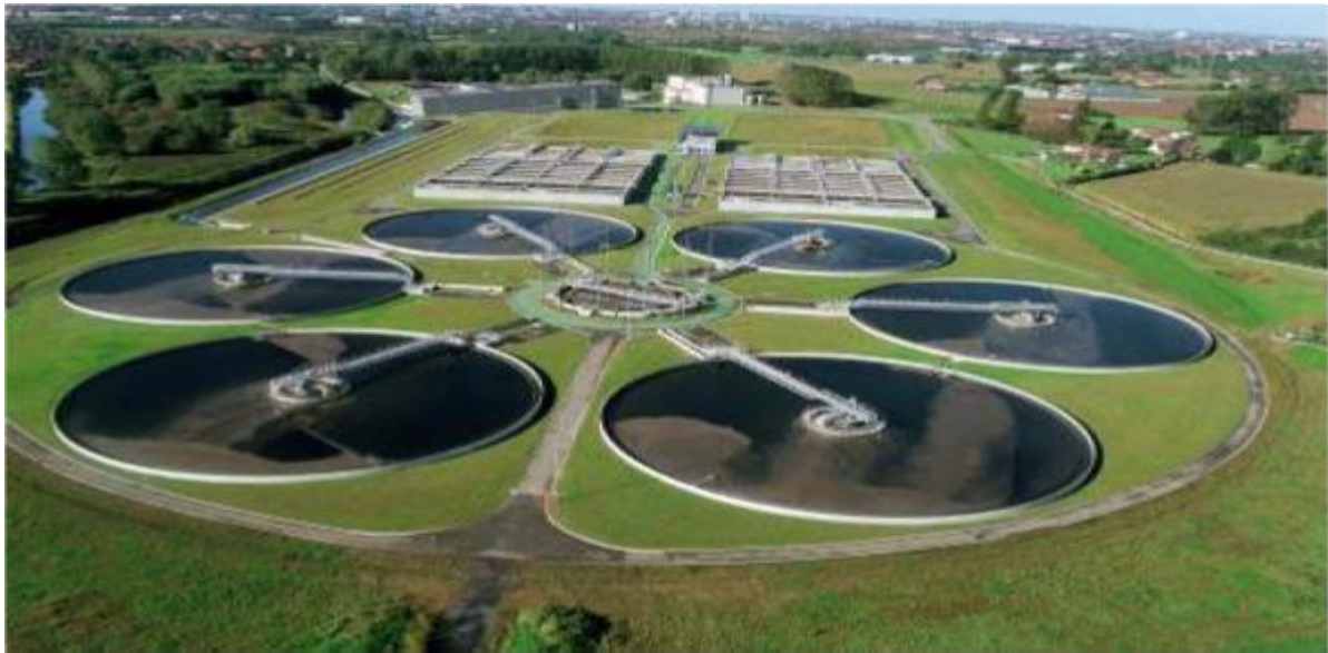
Figure .I.5: Vue aérienne d'une station d'épuration
