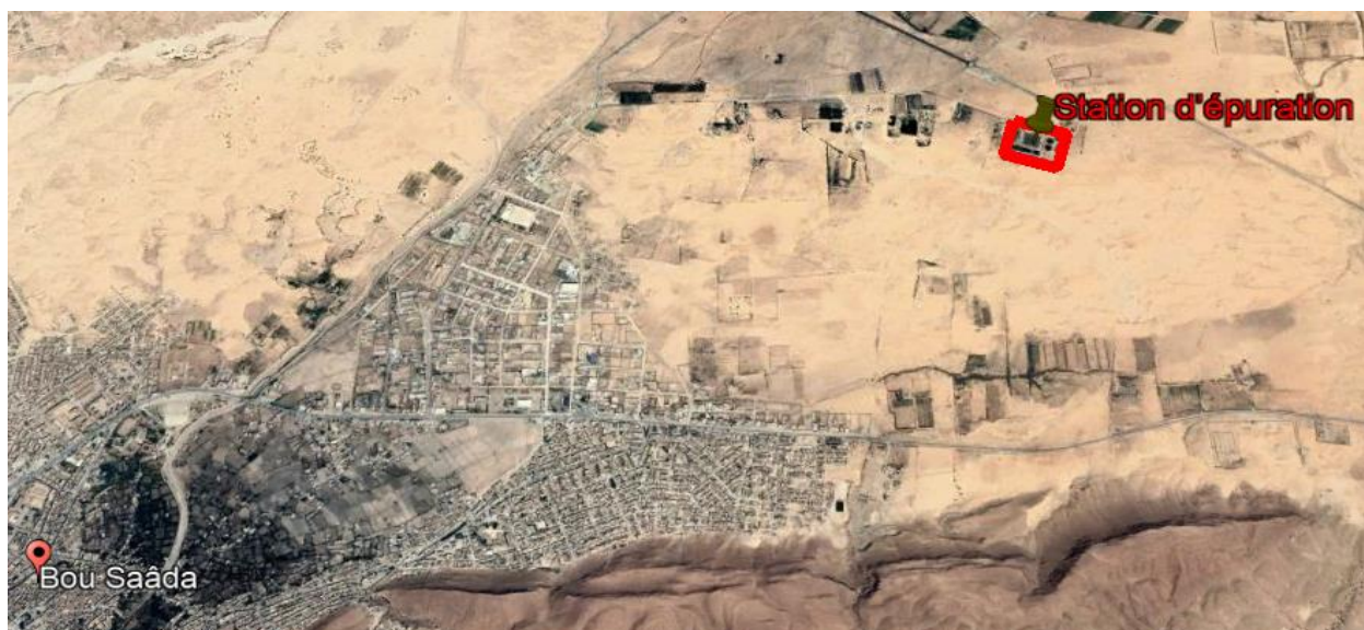
Figure II.6 : : Situation géographique de la STEP de Bou Saada (Google maps)
