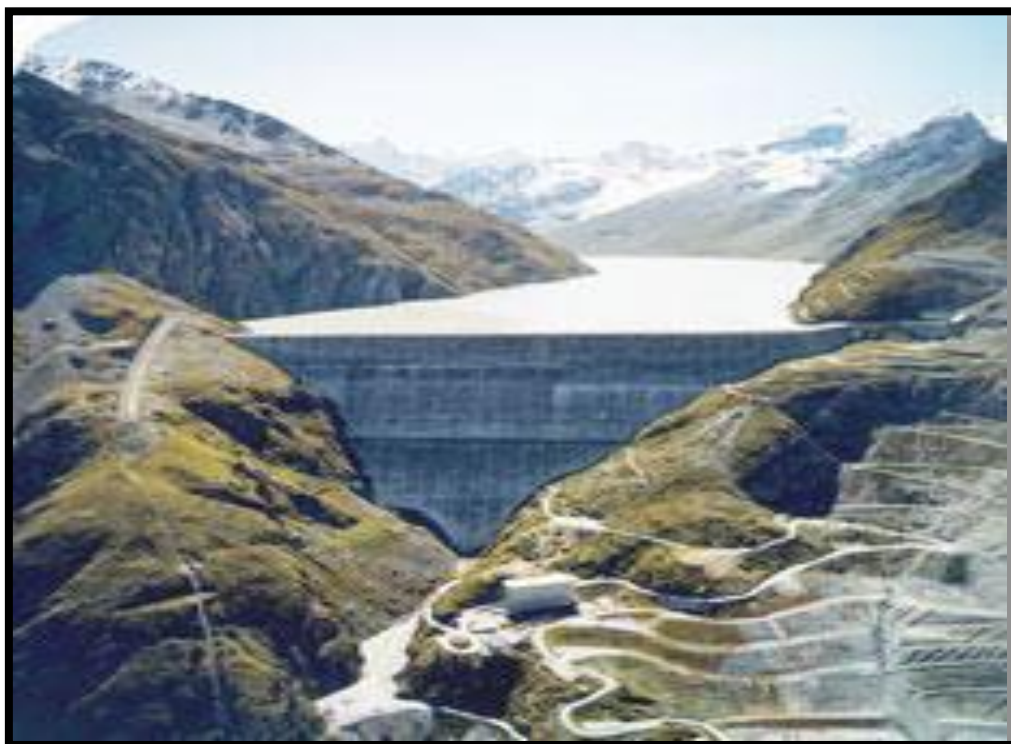
Figure I.2. Barrage poids de la Grande Dixence (Suisse)
