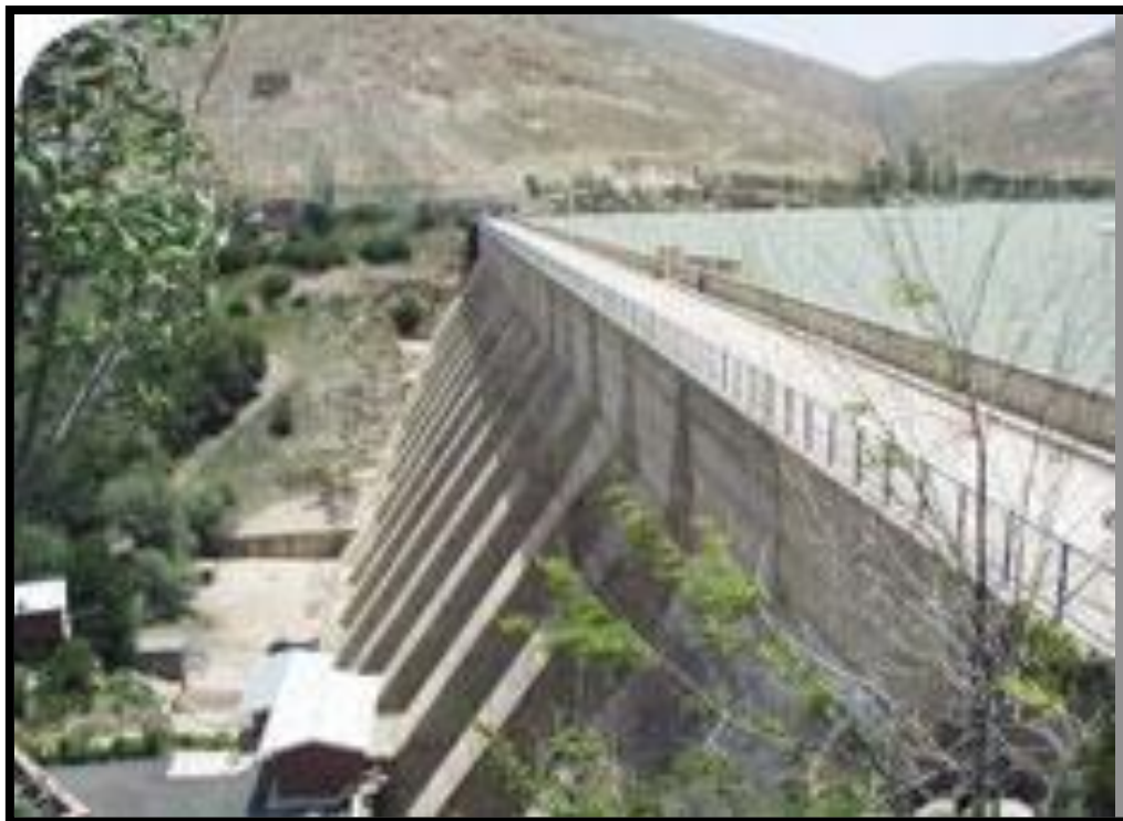
Figure I.6. Barrage à contreforts d'Ekbatan (Iran)
