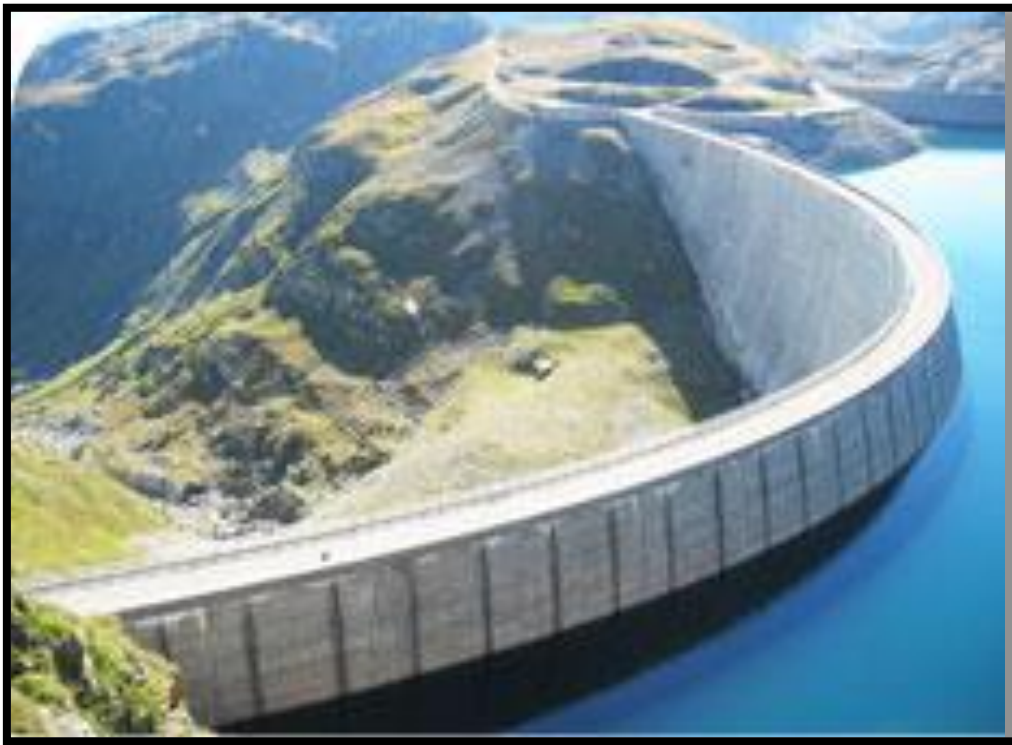
Figure I.4. Barrage voûte de Naret 1(Suisse)
