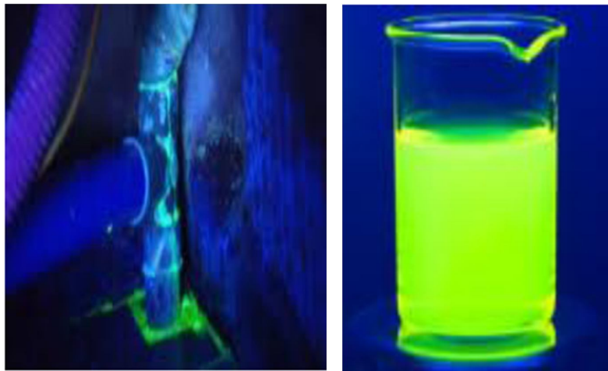
Fig. II.9. Recherche de fuite avec Fluorescéine
