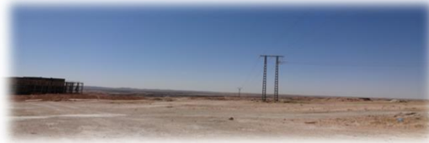
صورة رقم توضح عائق خط الكهرباء ذو الضغط المتوسط
