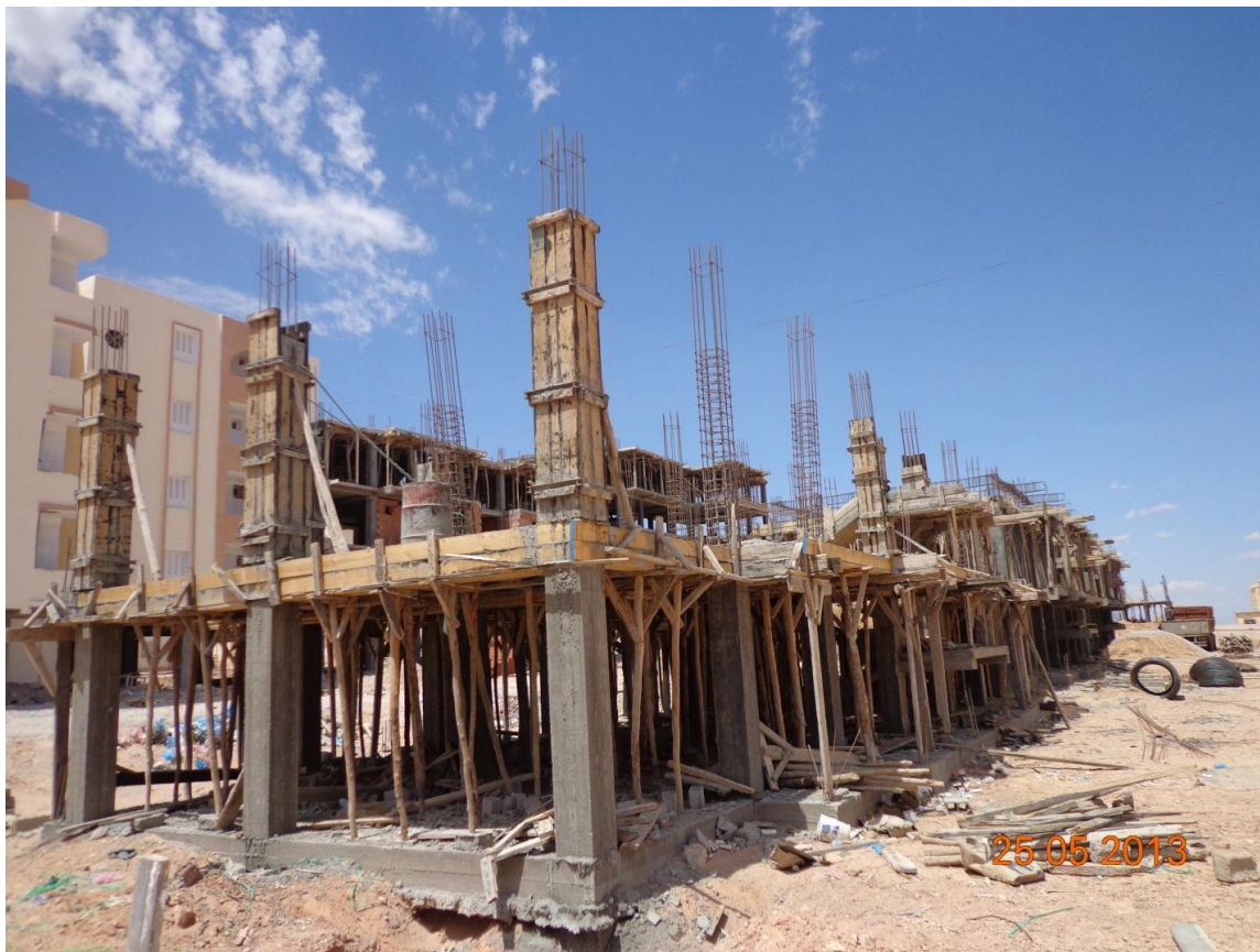
Figure6-coffrage des poteaux et des poutres
