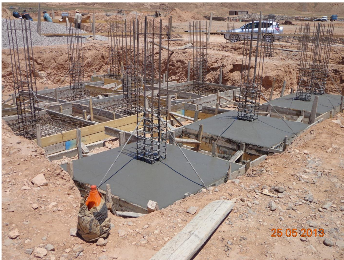
Figure5-coffrage et coulage des semelles
