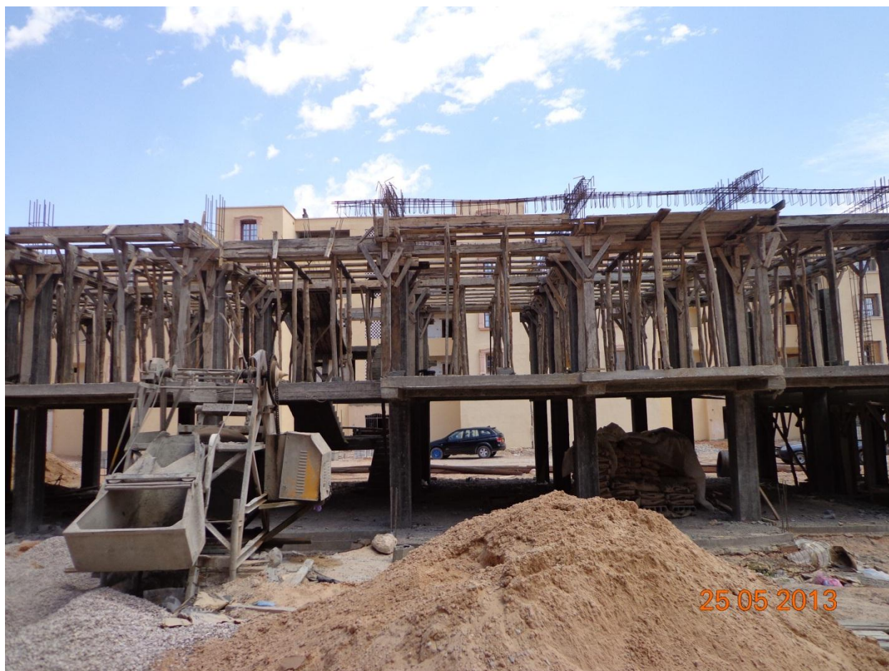
Figure7-coffrage des planches
