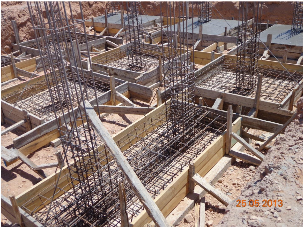
Figure3-coffrage des semelles
