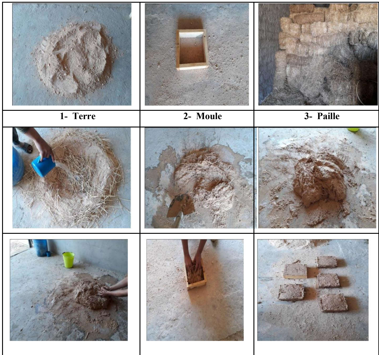
Figure II.6 : Etapes suivies lors de la construction des murs en briques anciennes.
