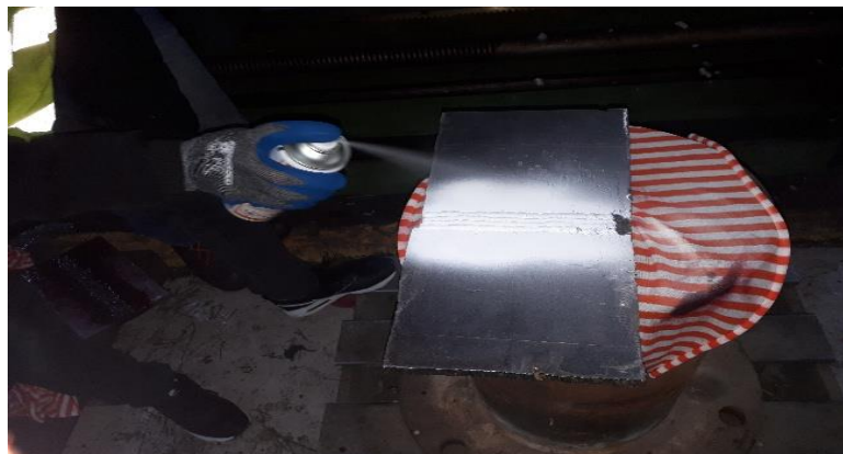
Figure IV.13 : Application d'une couche de peinture blanche.
