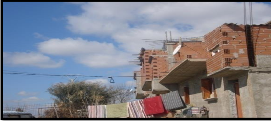
الصورة رقم (04): بنايات من الصلب المنتهي.
