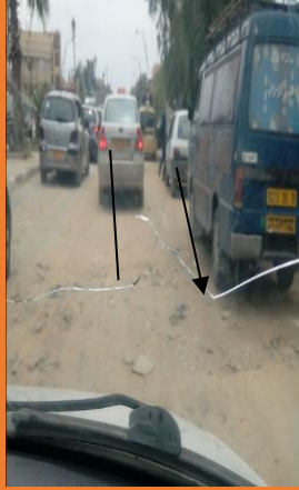
الصورة رقم 23: حفرة ابعادها 2*8 تتوقف فيها الحركة امام ( 1000 )
