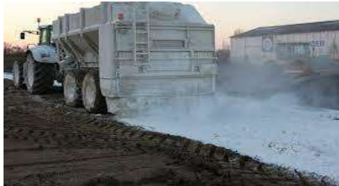
Fig. 1.3 Traitement à la chaux
