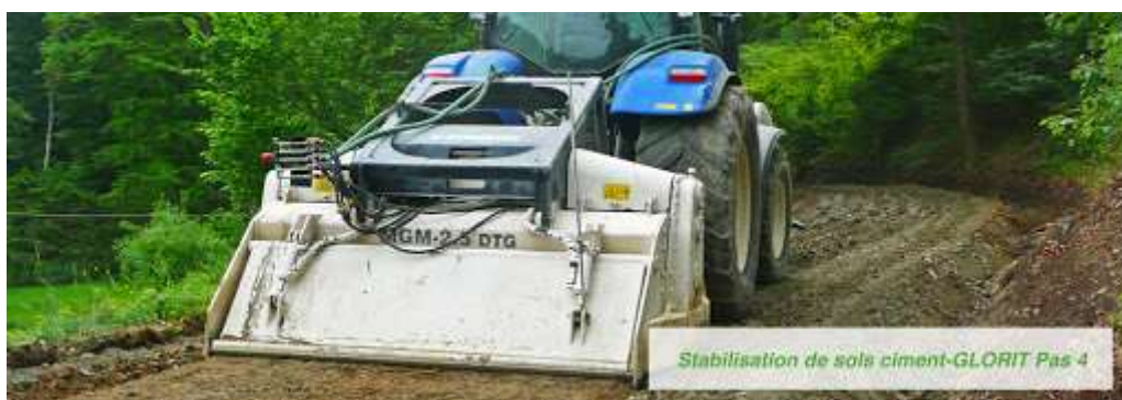
Fig. 1.4. Traitement par ciment
