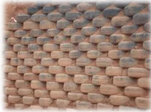
Figure 1.13 : Ouvrage en Pneusol
