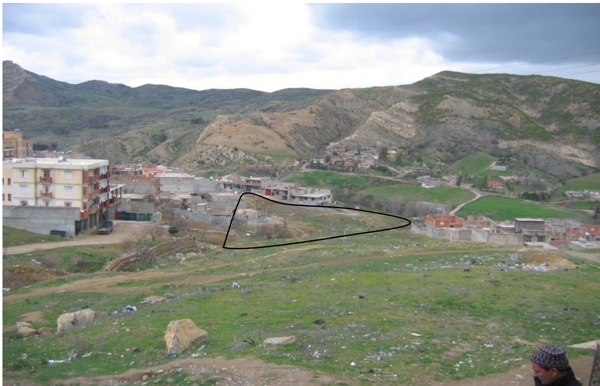
Figure III.1 : Vue d'ensemble du glissement de Beni Khellif
