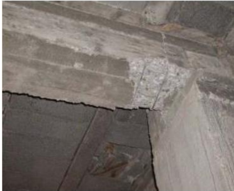
Figure II.16 : Rotule dans la poutre [31].
