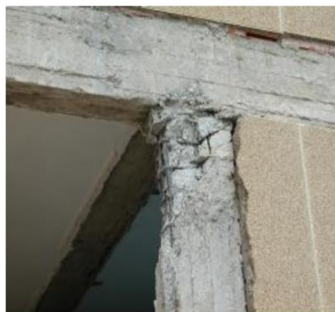
Figure II.15 : Rotule dans le poteau [31].
