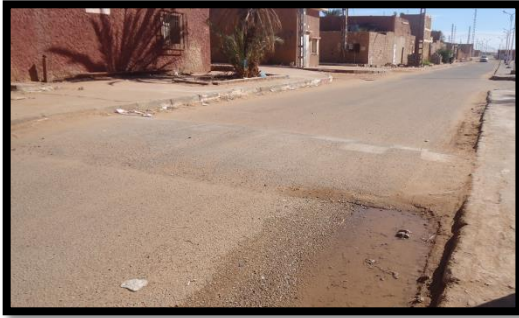
الصورة رقم 38: ممهل لا يحقق مرور مياه الأمطار.
