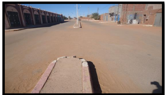
الصورة 32: طريق في الجزء الجنوبي.
