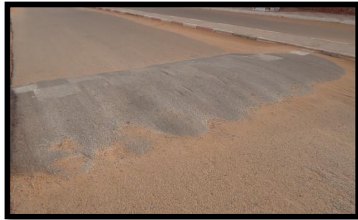
الصورة رقم 37: ممهل سطحه ليس له شكل هندسي.
