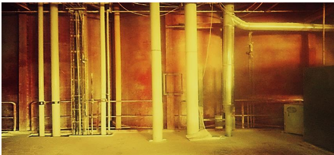
Figure III.11 : Silos de stockage de produit fini.
