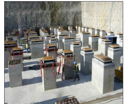
Figure IV.5 : Hôpital Pierre Zobda-Quitman sur appuis parasismiques. (France)
