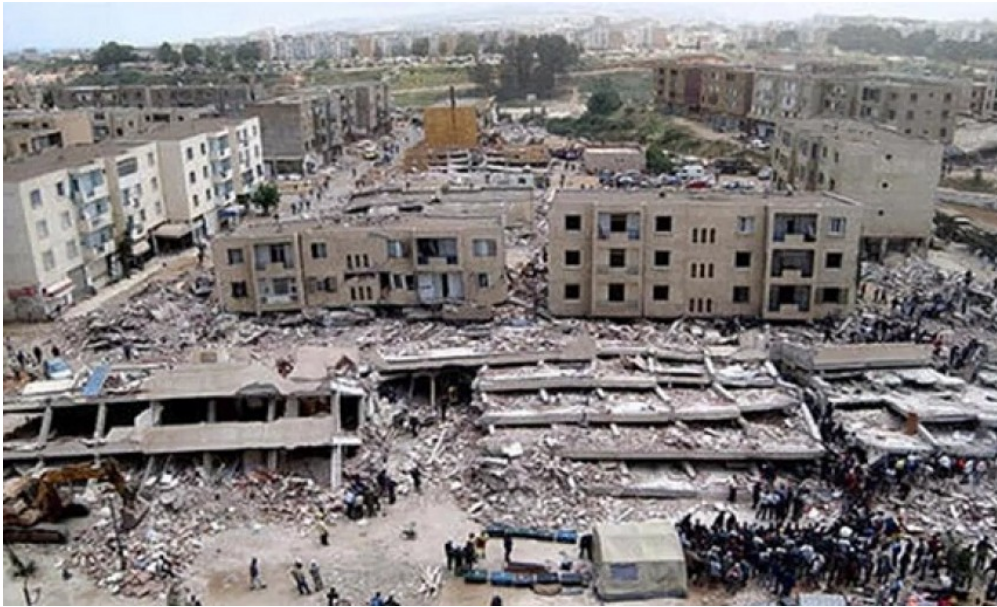
Figure I.1 : Séisme du 21 Mai 2003, Wilaya de Boumerdes.
