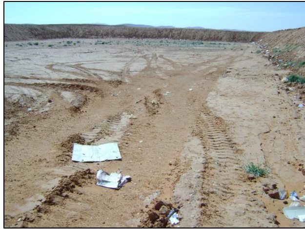
الصورة رقم(26): انجاز الحفرة الثانية
