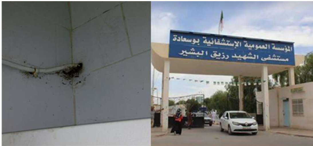
Figure 7. L'hôpital de Boussaâda (S02) (Dehim et Boutaiba, 2020).
