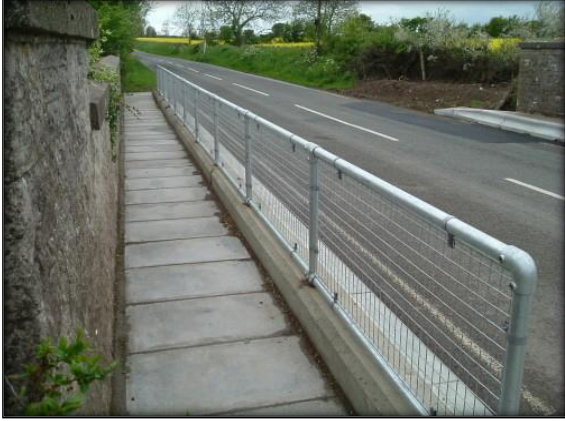
الصورة رقم (02): السياج الحامي للمشاة عند الارصفة
