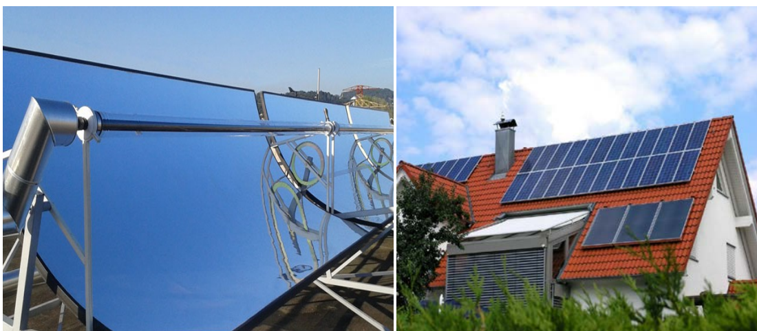
Figure(I.9) les différences modèle de panneaux entre solaire photovoltaïque et solaire thermique
