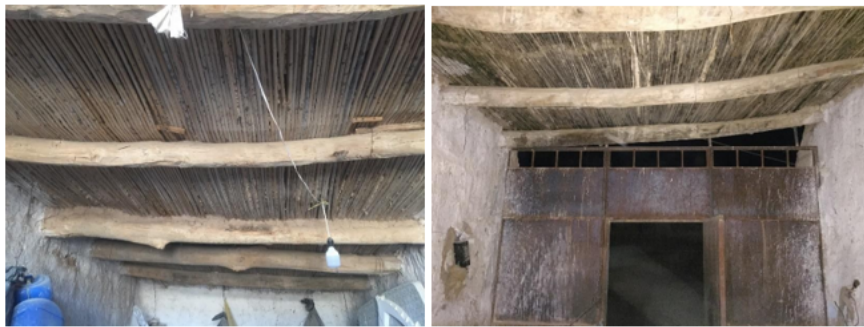
Figure I.3: toiture en bois (maison ancien).[3]
