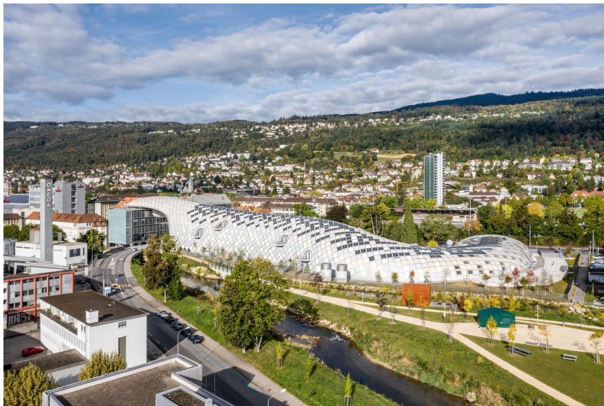
Figure I.24: Structure en bois lamellé-collé au siège social de Swatch à Bienne, Suisse [21]
