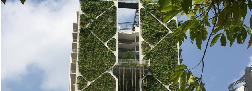
Figure I.27: Mur végétal à fonction isolante et décorative [24]
