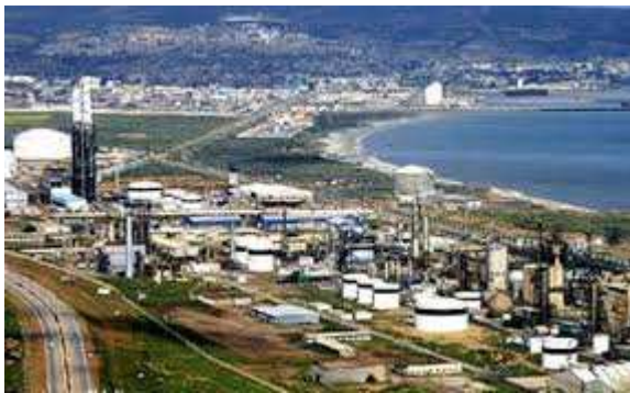
Fig. I.3) Complex GNL Arzew
