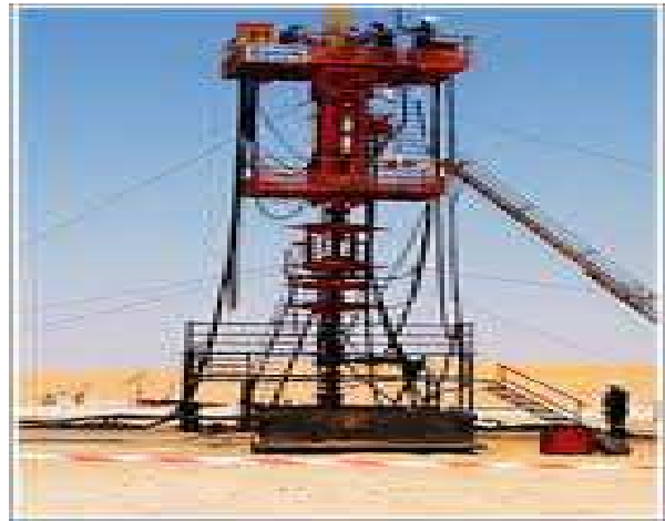
Fig. I.2) Opération de forage
