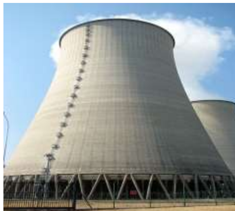
Fig I.12 : Tour de refroidissement
