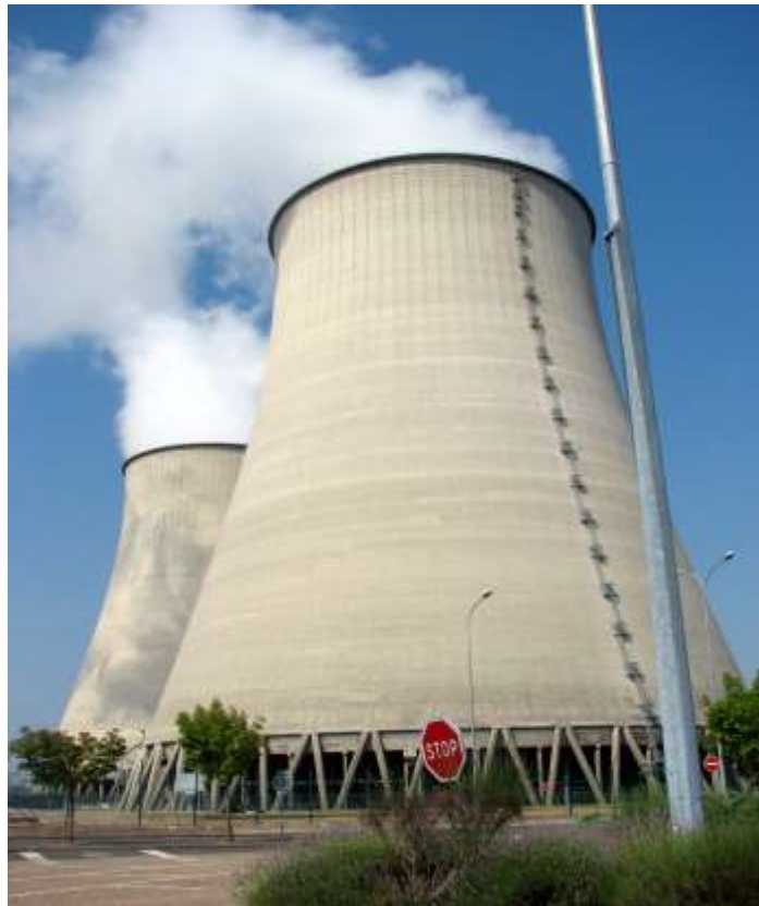
Fig I.6 : une tour de réfrigération
