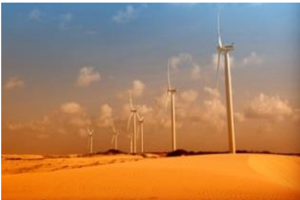
Figure I.6 1 er ferme éolienne en Algérie d'Adrar
