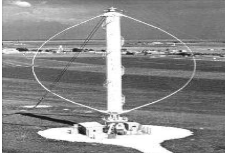
Figure I.13 Schéma du rotor de Darrieus [22].
