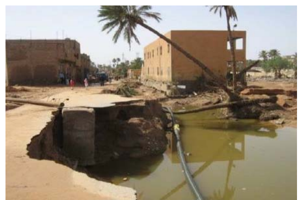
Figure I.14. Montrant l’ampleur des dégâts de l’inondation du Ghardaïa en octobre 2008 (Source Google)
