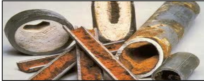
Fig.II.5. Formation de calcaire sur la paroi interne de la conduite
