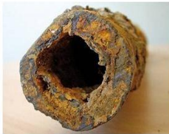
Fig.II.1. Vieillessement des canalisations.
