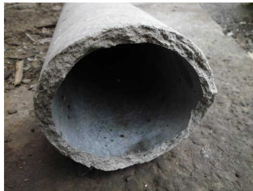
Fig.IV.6. Photo de conduite est en amiante ciment
