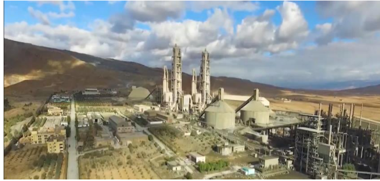
Figure II.1 : Cimenterie LH de Hammam Dalaa - M'sila [9].
