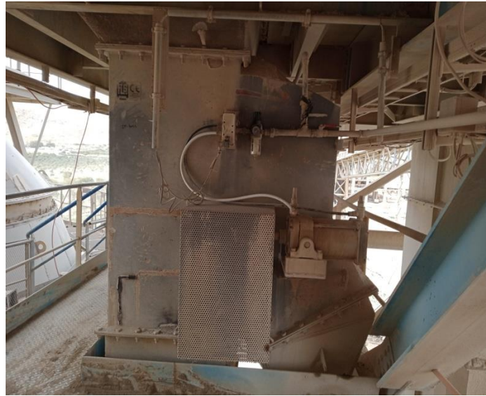
Figure II.6: Vue d'un Clapet matière [9].
