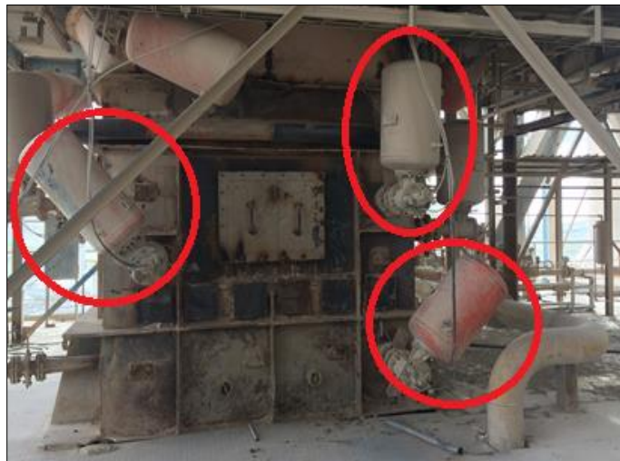
Figure II.12: Disposition des Air-chocs au niveau du calcinateur [9]
