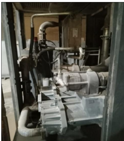
Figure II.15: Composantes d'un compresseur Atlas Copco GA 250 [9].
